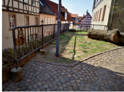
Hier entsteht die Sicherungsmauer
