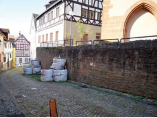
Notsicherung der Mauer
